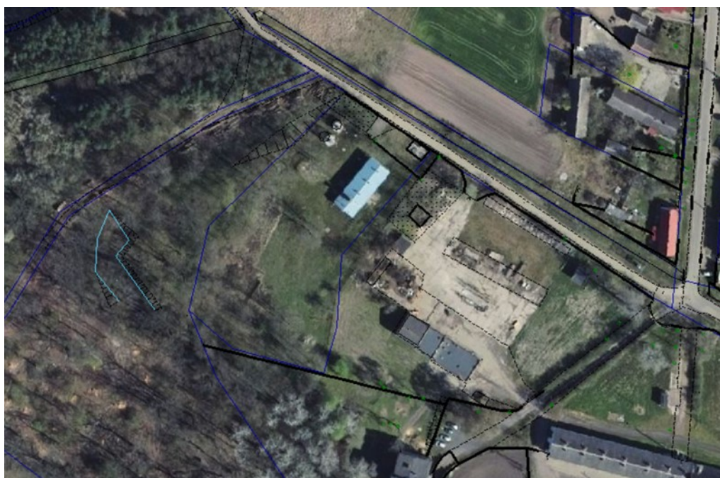
Rysunek 16 - Ujęcie wody „Wilków” wraz ze stacją uzdatniania wody, na dz. nr 591/11 (obręb Wilków) – strefa ochrony bezpośredniej zlokalizowana jest w granicach dz. 591/11 (źródło: Geoportal Powiatu Głogowskiego)
