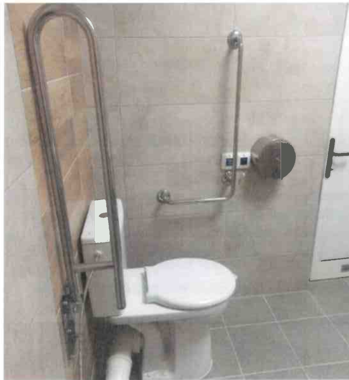
Toaleta dostosowana do potrzeb osób z niepełnosprawnościami w SP Wilków
