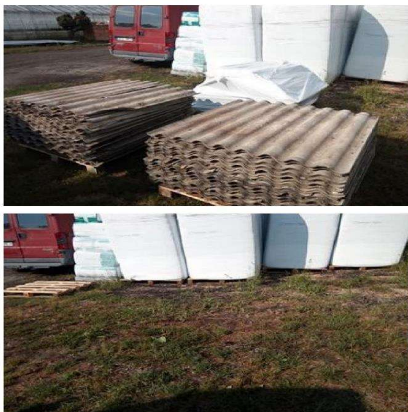
Złożony azbest na jednej z posesji w miejscowości Serby oraz miejsce po usunięciu azbestu
