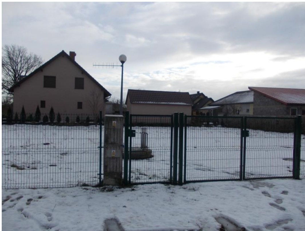
Rys. 5. Stan techniczny przepompowni przy ul. Kwiatowej
