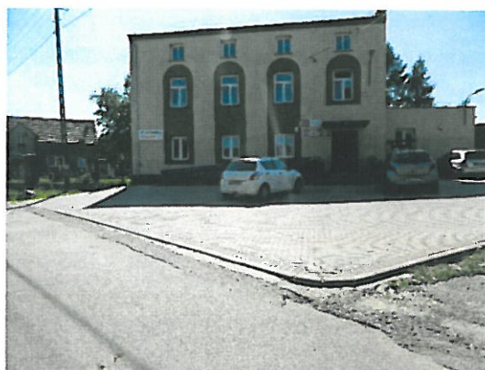
Rysunek 43. Budynek Gminnego Ośrodka Kultury i Gminnej Biblioteki Publicznej w Przedmościu (źródło: CDE Sp. z o.o.)
